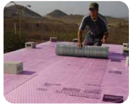
**3** Instalar malla metálica para reforzar el empastado.
