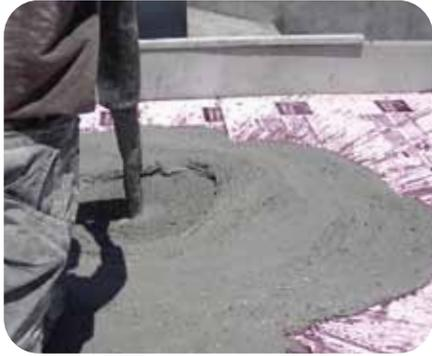
**4** Aplicar empastado cemento-arena con un espesor mínimo de 3 cms.
