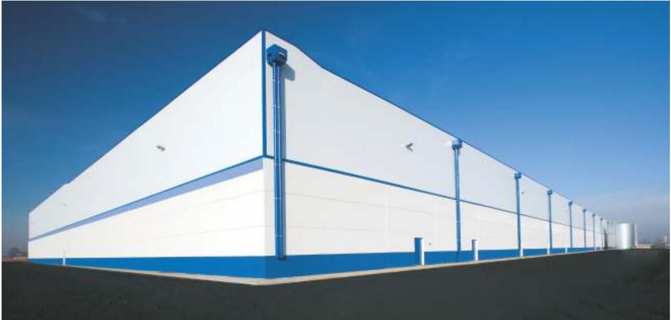
Panel de fachada de doble revestimiento metálico con aislamiento en espuma rígida de poliuretano o poliisocianurato según requerimiento. La junta machihembrado es de fijación oculta con tornillo pasante. Cara externa disponible en perfilado Plissé, Box y Plano. La cara interna en perfilado Box, en acabado PVC. **Se aconseja utilizar el acabado de PVC en ambas caras para muros internos solamente.** La guarnición permite una mejor unión entre piezas, así como una mejor fijación en plafón.
