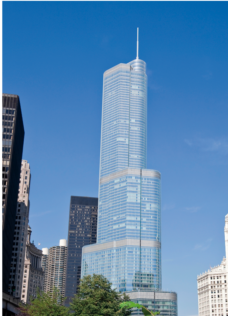
El aislamiento de lana mineral FireSpan® de Thermafiber® provee los componentes críticos y necesarios del sistema de contención de incendios perimetral del Hotel Internacional Trump, así como la torre en Chicago, IL.
