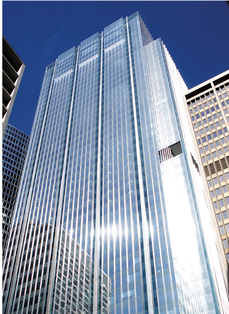
Los productos de lana mineral Thermafiber® Safing y FireSpan® proporcionan los componentes críticos del perímetro del sistema de contención de incendios en el edificio 111 South Wacker en Chicago, IL. El aislamiento de lana mineral Thermafiber® también contribuyó a la calificación de oro LEED® del edificio.
